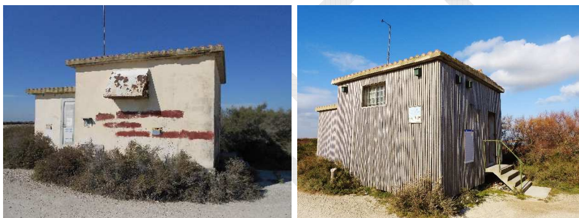
Illustration 31 : Ancien transformateur du Galabert avant rénovation (à gauche), après rénovation (à droite) ©S. Ceyte / PNRG
