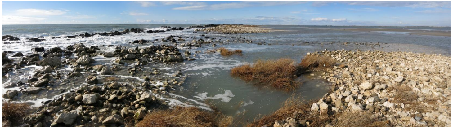
Ancienne digue au droit de l'étang de Beauduc
